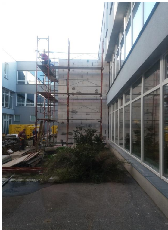
Foto: Přístavba výtahu uvnitř vnitrobloku školy
