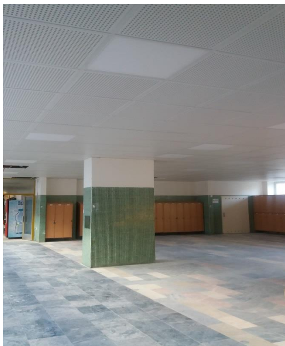
Foto: Stavební práce – nové podhledy v šatnách
