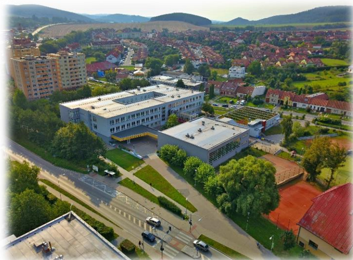
Budova na ulici Tyršova
